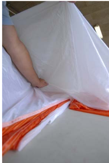
Abb. 42 Bahn Nr. 3 nach aussen streichen (S-Schlag)
